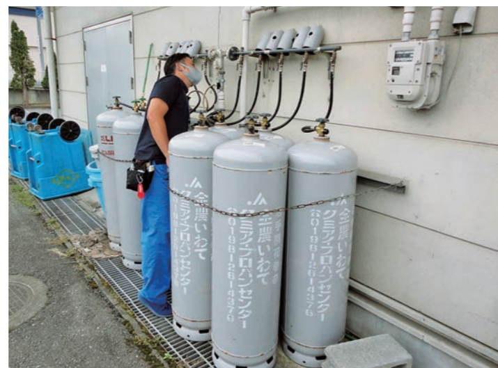
供給設備調査点検の様子
