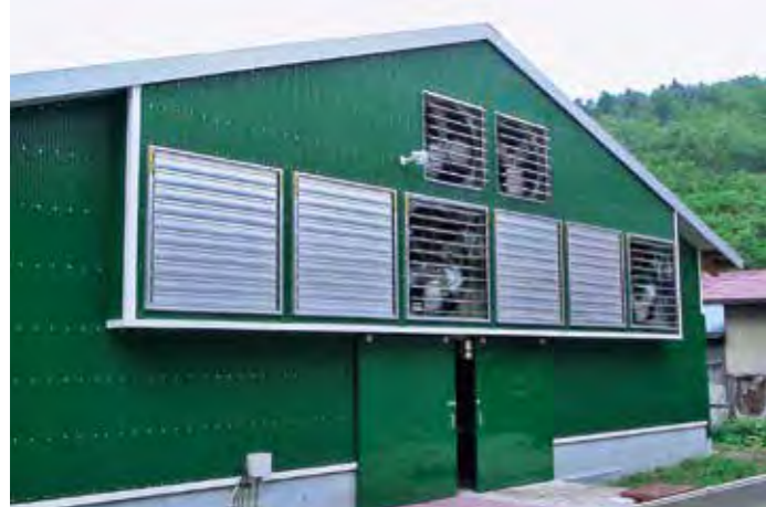
強制換気システム
